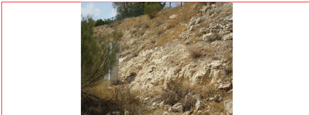
אזור תכנון 3 – מבט על קיר חיצוב המתנשא לגובה עד גדול מ-4 מטר באזור מפגש כביש מס' 3 ו-13. בפני קיר החיצוב נחשפים סלעי השתית הטבעית השולטים באזור שעיקרם גיר דולומיטי עד דולומיטי גירי, קשה.
